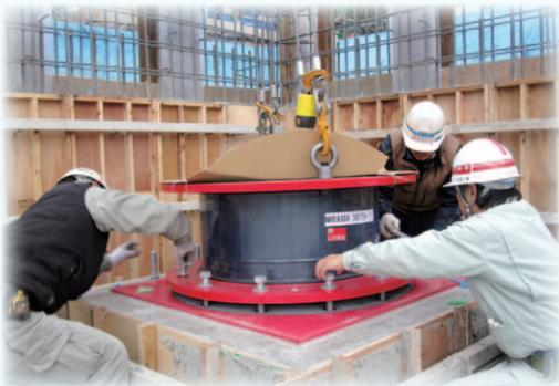
現在、地下の免震装置の設置が終わり、1階の床部分までの工事を行っています。
